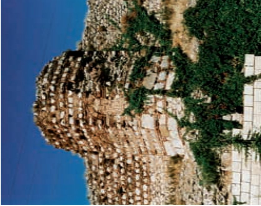
7 Egirdir, Burg – Südabschnitt, Turm: c.) „Wohnturm“, byz. Kasteilmauerwerk
